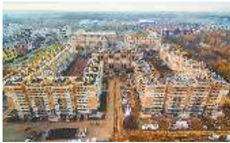
ЖК «Новое Янино», Ленинградская область ГК «ЦДС»
