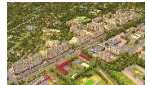
ЖК «Петровский», Свердловская область «Элит-групп»
